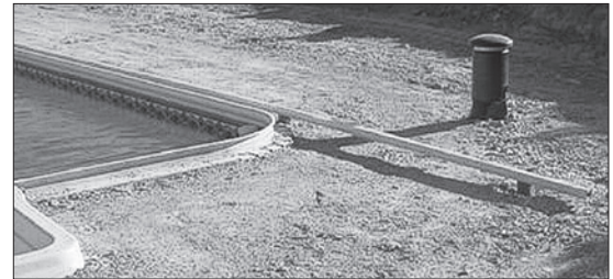
(4.a.) Guide staked in place, ready for pour
