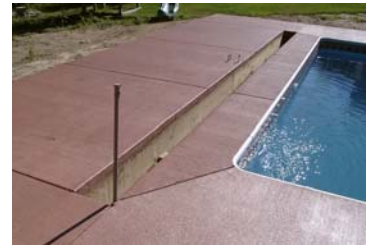
Conduit roughed in correctly.
